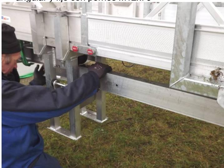
8. Extienda la pieza en forma de U añadiendo otros 2 tubos para los lados largos, usando las piezas de conexión y pernos M12x70.
