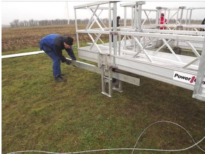
9. Instale las piezas de conexión angular y ajuste el tubo lateral corto de cierre.
