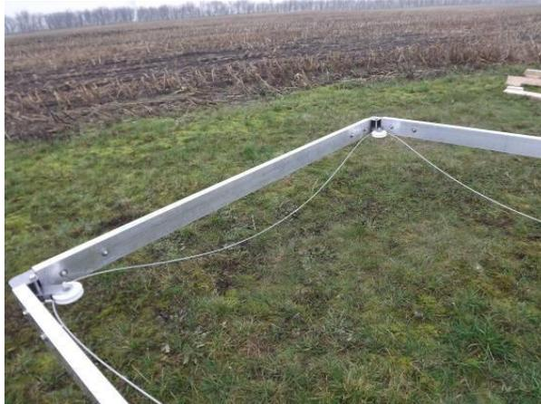
12. Fije el punto de conexión para el gancho al área opuesta de la plataforma y conecte el gancho.
