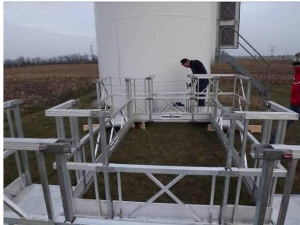
3. Instale el estribo exterior en los lados largos de la plataforma. **La posición del estribo debe estar entre los 2 marcadores rojos fijados al carril del medio de la plataforma.**
