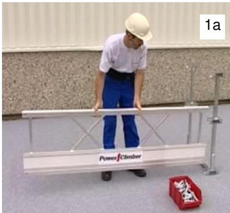
1. El proceso de montaje comienza en la sección central y continua hacia cada extremo de la plataforma. Empezar colocando una lira de conexión y dos laterales. Fijar cada lateral a la lira mediante dos pasadores Safefix.
