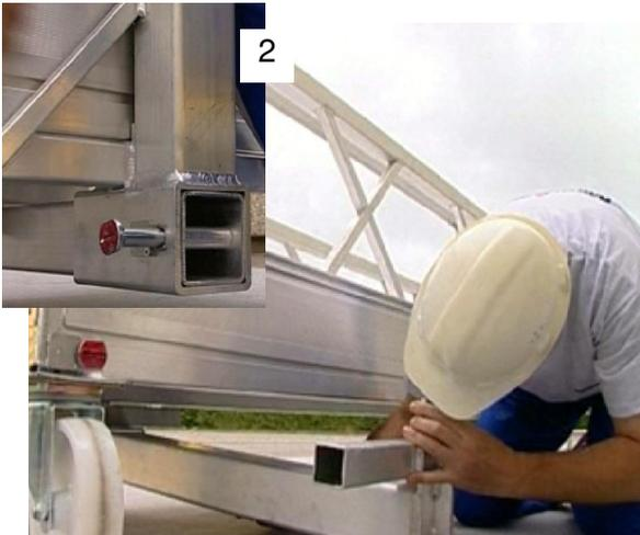
2. Insertar la parte baja en el mástil y fijar con pasadores SafeFix, asegurándose que la lengüeta delantera está correctamente encajado con el conducto de la parte frontal del lateral.
