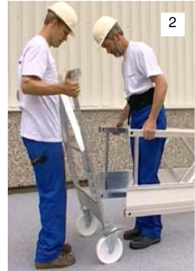
2. Continuar el montaje con las liras de conexión y los laterales hasta obtener la longitud requerida de la plataforma y terminar instalando la lira extrema.
