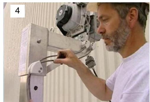
5. Führen Sie das aus der Winde auslaufende Trag- und Sicherheitsseil in die Seilführung ein.
