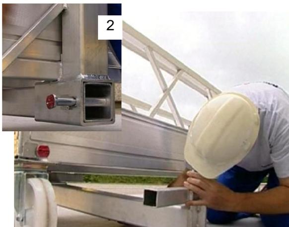
3. Nehmen Sie den oberen waagerechten Arm mit der Windenaufhängung vom C-Bügel und positionieren Sie ihn auf dem Masten, auf erforderliche Höhe. Sichern Sie ihn mit einem SafeFix Bolzen (Bild 3).
