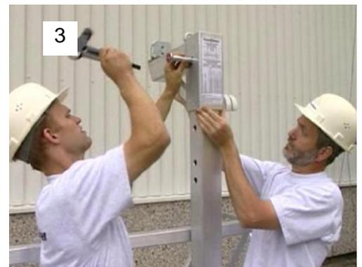
4. Montez le treuil (voir installation du treuil) et passez les deux câbles acier dans le déviateur.
