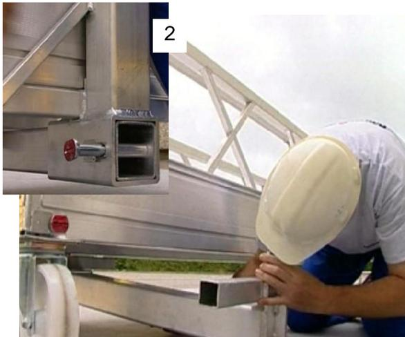
2. Insérez la partie inférieure du mat et verrouillez là avec une goupille Safefix longue. Assurez-vous que la patte avant est bien placée dans la rainure du garde-corps.
